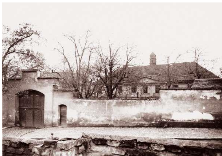
Bečvářův dvůr před rekonstrukcí
